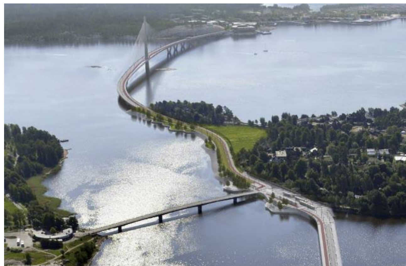
Kruunusillat, Helsingin kaupunki, Helsinki
